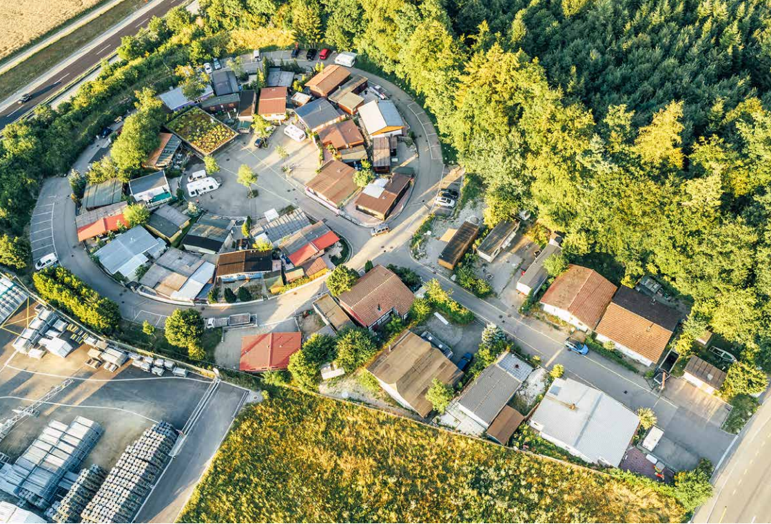
Dichte wagenburgförmige Anordnung der Bauten auf dem Standplatz Bern-Buech. Das begrünte Flachdach am Ende der Wagenburg ist das Gemeinschaftsgebäude mit Aufenthaltsraum und Waschküche.
